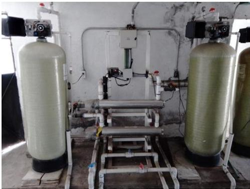
Figuras 1. Filtros de arena para la desinfección del agua de riego.
