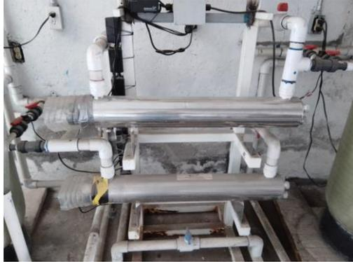
Figura 2. Lámparas UV para la desinfección del agua de riego.
